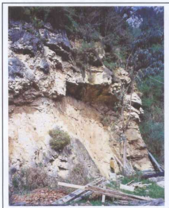
Fig. 158: Aspecto general del frente de cantera, prácticamente coincidente con un plano de fractura
